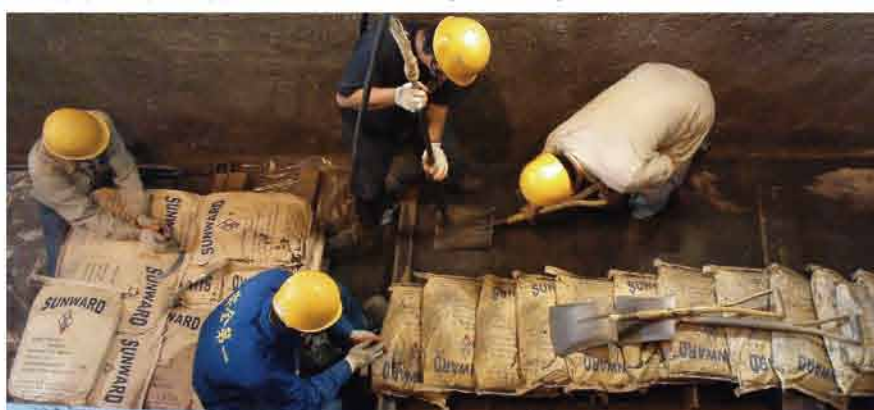
● 搗固材施工 Ramming.
